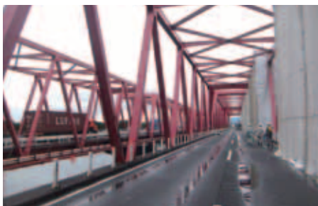
揖斐長良大橋・塗装ヤード
