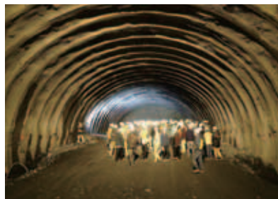
現場見学会の様子(東海環状自動車道北野トンネル)
