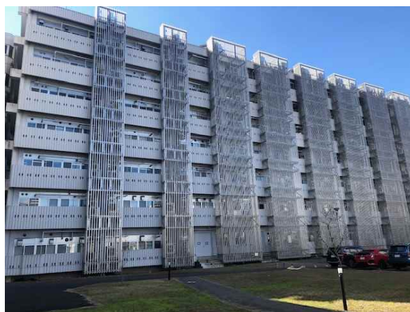
図6．改修後のC棟外観
