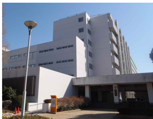
図2. 改修前後の工学部棟の様子 （上図：改修前，下図：改修後）
