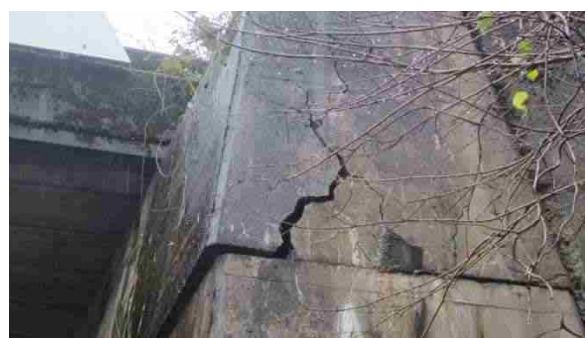
図 2. アルカリシリカ反応が生じたロックシェッド
