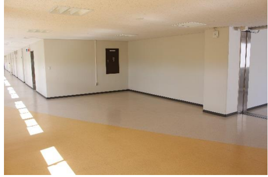
4階ホール東側
